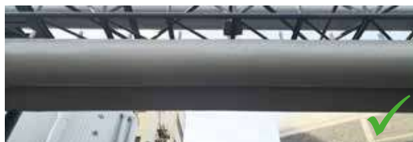
Тусгаарлах хамгаалалтыг импульсын зурвасын гадуур ороосон
